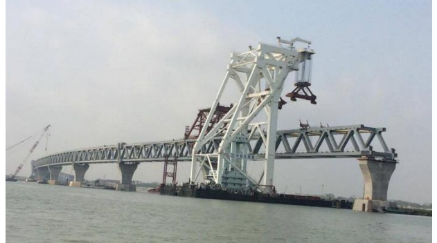
স্থাপনা নির্মাণ (ব্রিজ)
