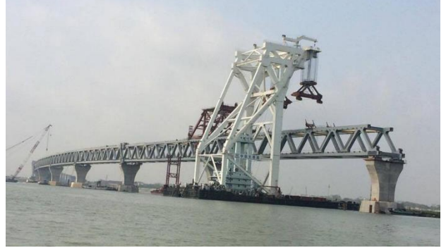
স্থাপনা নির্মাণ (ব্রিজ)
