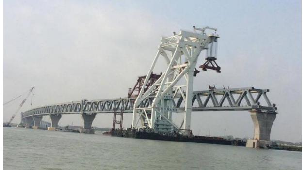
স্থাপনা নির্মাণ (ব্রিজ)
