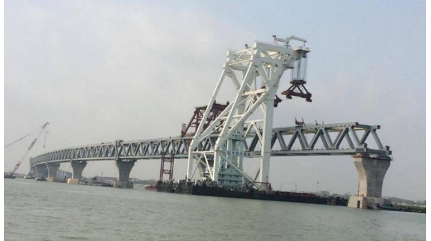
স্থাপনা নির্মাণ (ব্রিজ)
